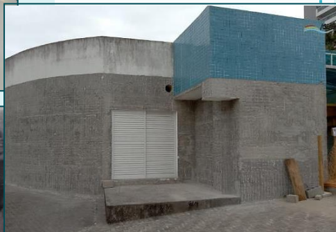
EEE Península Impermeabilização das paredes
