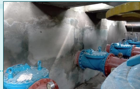
EEE Península Impermeabilização das paredes
