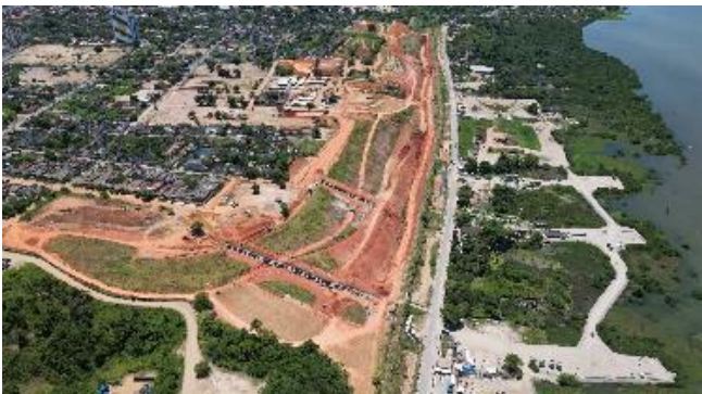
Obras para estabilização e drenagem da Encosta do Mutange
