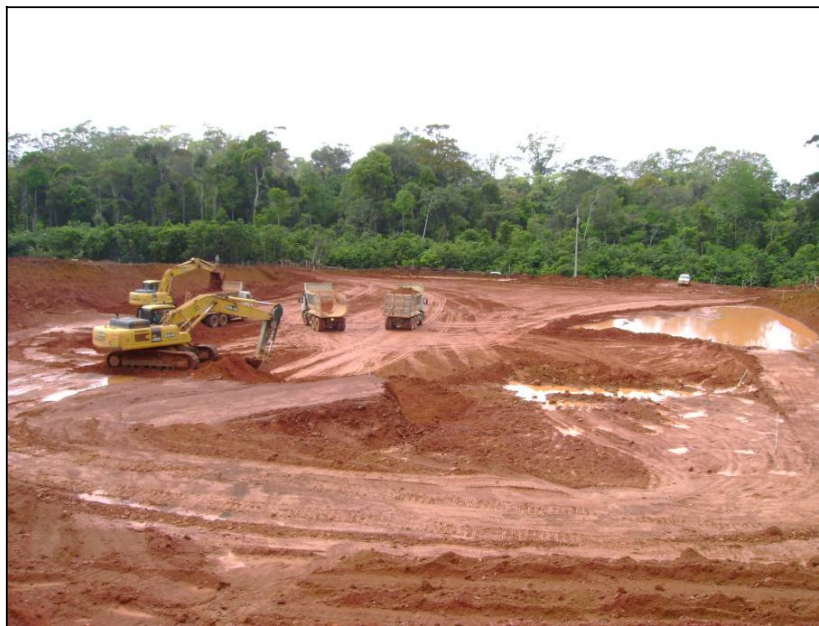
Figura 3.3-2 Preparação do Local em Serra do Navio
