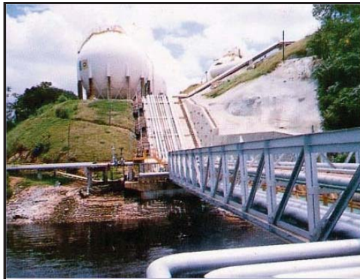
Foto: Refinaria de Manaus - AM
