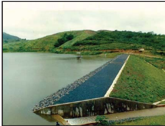
Foto: Barragem de Canabrava – MG
